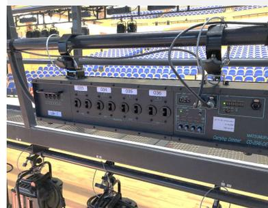
参考) 200V D直BOX/3回路 (DMX制御ON/OFF)
